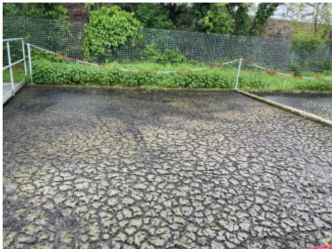
Figura 14: Letti di essiccamento fanghi presso il depuratore di Ferratella sito a Castelnuovo del Garda
