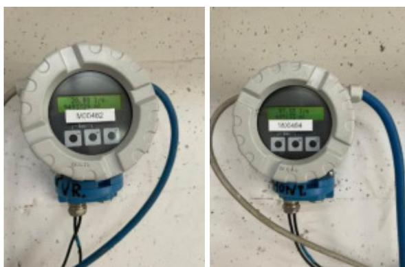
**Figura 19: Misuratore di portata delle acque erogate verso Verona e verso Montorio**
