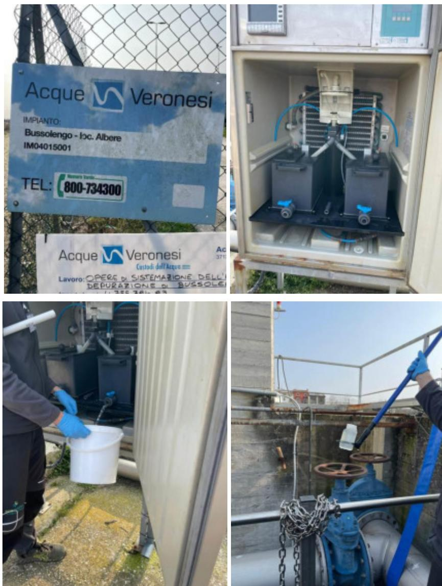
**Figura 31: Targa dell'impianto – auto-campionatore 24 ore – campione istantaneo a valle della disinfezione**
