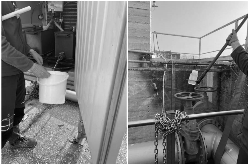
Figura 2-14: Targa dell'impianto – auto-campionatore 24 ore – campione istantaneo a valle della disinfezione.
