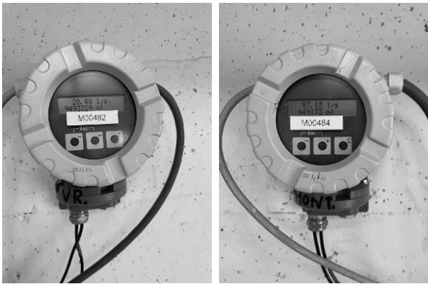
Figura 2-2 - Misuratore di portata delle acque erogate verso Verona e verso Montorio.
